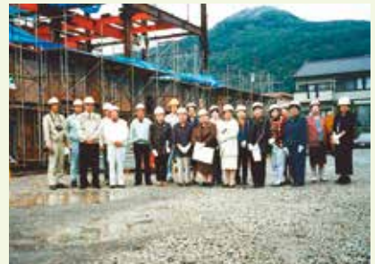
看護教育研修センター 工事見学
