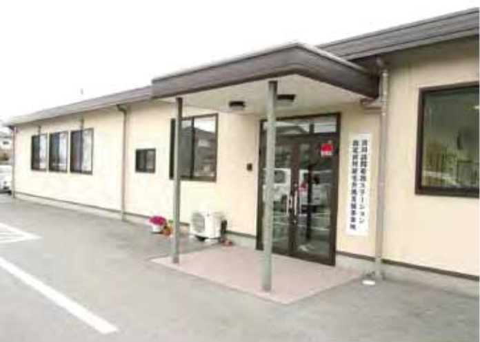
■箕川訪問看護ステーション（平成24年4月 竣工）
