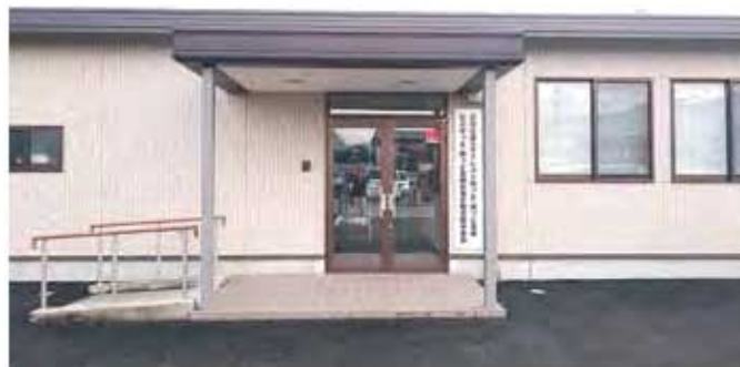
■訪問看護ステーションほっと・ほっと蒲崎（平成23年3月竣工）
